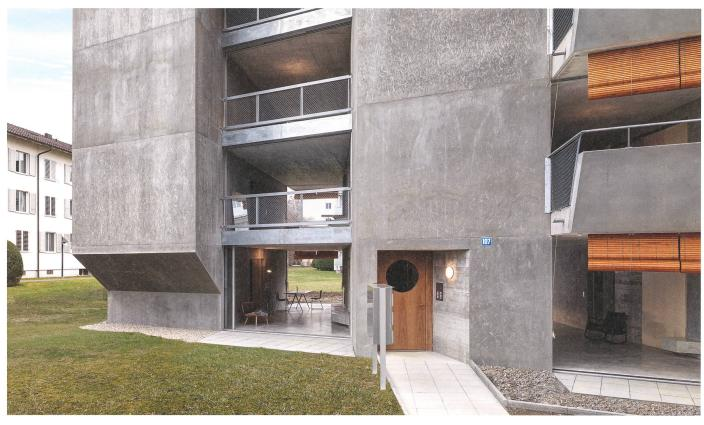
Innenraum ist Aussenraum: Der durchgehende Wohnraum lässt sich dank Schiebefenstern vollständig öffnen; Der Beton hat dank der Schalung mit OSB-Platten bereits Patina.
