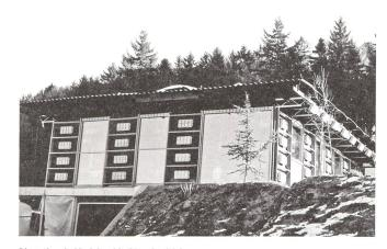
Die rationale Modularchitektur des Wohnhauses im Ziegelried ist auf die Montage von Hand ausgelegt; die kleinen rechteckigen heilen Elemente in den Rahmen sind dekorativ gedacht und kaschieren die aussteifenden Drähte. Bild vom Zustand 1980: Lóránt Perényi
