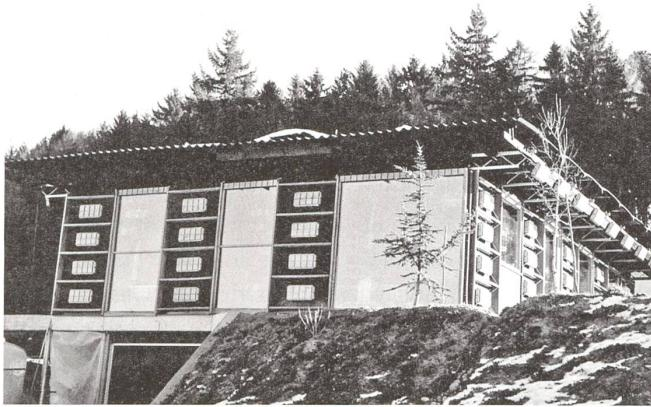
Die rationale Modulararchitektur des Wohnhauses im Ziegelried ist auf die Montage von Hand ausgelegt; die kleinen rechteckigen hellen Elemente in den Rahmen sind dekorativ gedacht und kaschieren die austiefenden Drähte. Bild vom Zustand 1980:
