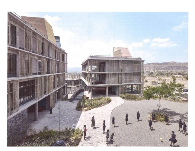
Noch sind nicht alle Bauten fertiggestellt und auch die umliegenden Gärten werden erst angepflanzt. Über dem Sockel mit den Erdregistern für kühle Zuluft türmen sich zwei Schulzimmergeschosse, darüber zwei Etagen mit Schlafsälen.
