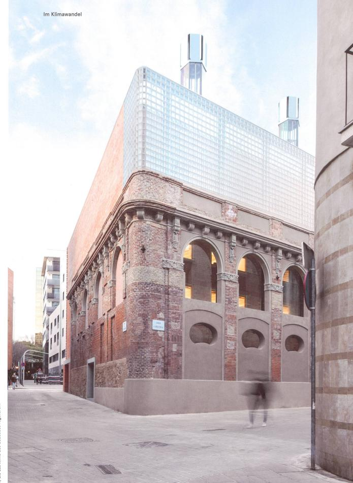
Die neubarocke Pfeilerfassade auf der Südostseite der Cristalleries Planell trägt einen Aufsatz aus Glasbausteinen, darüber ragen die Solarkamine hervor, die das Klima des Gebäudes regulieren.
