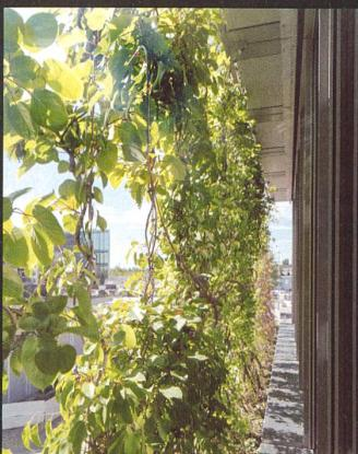
Hydroplant schafft faszinierende Fassadengärten, die ihren Charakter laufend verändern, das Tageslicht filtern und zur Klimatisierung des Gebäudes beitragen, zudem erhält das Gebäude durch die Fassadenbegrünung zusätzlichen Charakter.
