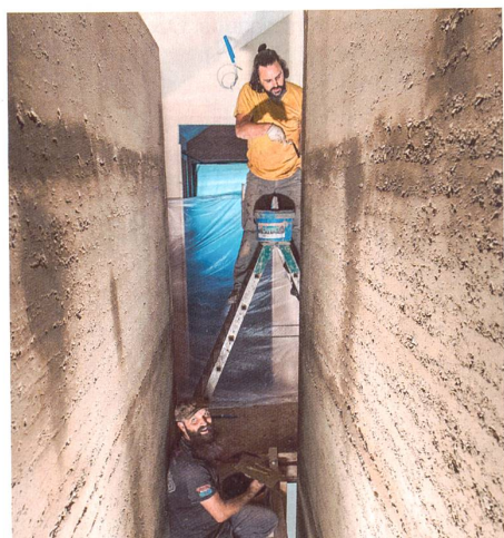
Idealer Partner zum Vollholzhaus ohne Nägel und Leim: Treppenhauswände aus vorfabrizierten Stampflehm-Elementen aus dem Aushubmaterial bringen Feuchteregulierung und thermischen Wärmespeicher. Bilder: Samuel Büttler
