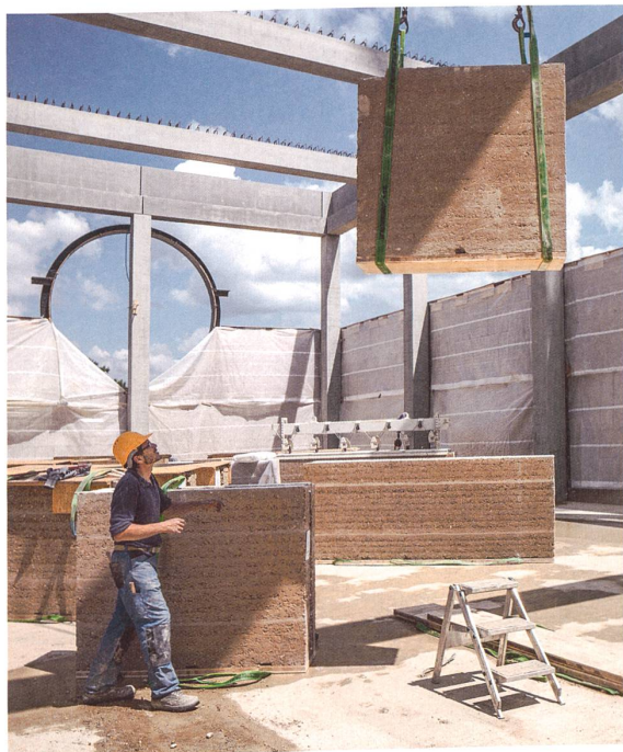
Vorfabrizierte Stampflehelemente stapeln sich vor dem Betonskelett. Ein Betonsockel und ein Wellblechdach schützen vor Feuchteintritt. Trasskalkschichten und zwei Armierungseisen stabilisieren die 11 Meter hohe Wand. Bilder: Iwan Baan, Herzog & de Meuron (links oben), Ricola
