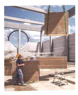
Vorfabrizierte Stampflehmelemente stapeln sich vor dem Betonskelett. Ein Betonsockel und ein Wellblechdach schützen vor Feuchteeintritt. Trasskalkschichten und zwei Armierungseisen stabilisieren die 11 Meter hohe Wand. Bilder: Iwan Baan, Herzog & de Meuron (links oben), Ricola
