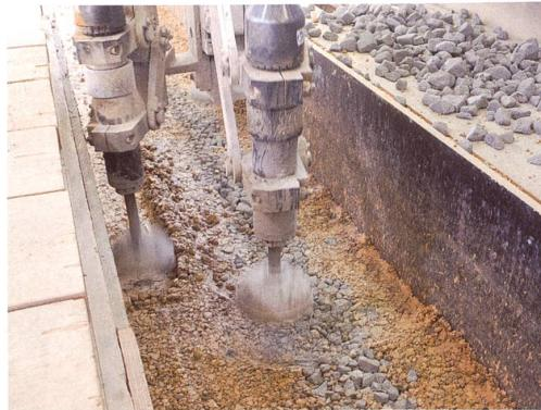
Für den Alnatura-Campus in Darmstadt (2015–18, Haas Cook Zemmrich, Studio 2050 mit Lehm Ton Erde) wurden die Elemente mit Kerndämmung aus Schaumglasschotter gestampft. Der Lehm stammt aus der Baugrube des Stuttgart-21-Grossprojekts. Auf der Baustelle werden die Elemente mit dem Kran zu den Wandmodulen geschichtet und die Fugen ausgefüllt. Bilder: Emmanuel Dorsaz
