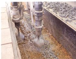
Für den Alnatura-Campus in Darmstadt (2015–18, Haas Cook Zemmrich, Studio 2050 mit Lehm Ton Erde) wurden die Elemente mit Kerndämmung aus Schaumglasschotter gestampft. Der Lehm stammt aus der Baugrube des Stuttgart-21-Grossprojekts. Auf der Baustelle werden die Elemente mit dem Kran zu den Wandmodulen geschichtet und die Fugen ausgefüllt. Bilder: Emmanuel
