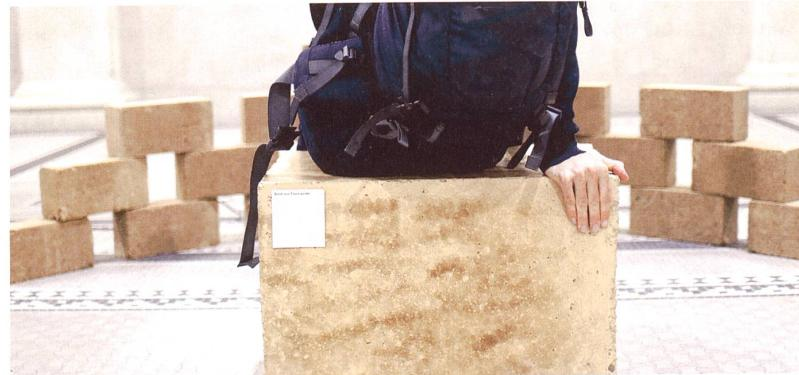
Oben: Roger Boltshauser forscht beim Stampflehm an einem System der Vorspannung (rechts das Mockup mit zwei integrierten Gewindestäben, welche die Vorspannung auf den Lehm aufbringen) sowie an der Nutzung des Speicherpotenzials vom Lehm (links das Mockup für das Ozeanium Zoo Basel). Einlagen von Leitungsregistern in der Lehmfasade ermöglichen eine Kälterückgewinnung. Bild rechts: Jan de Vylder, Bild links: Boltshauser Architekten, Kuster Frey
