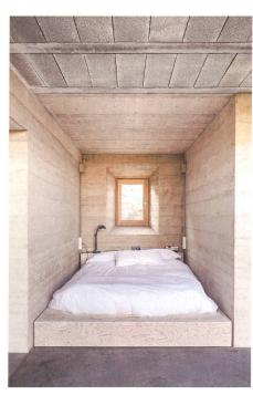
Plastisch strukturierter Innenausbau mittels massiven Lehmwänden: Wohnhaus in Ullastret von H Arquitectes. Bild: Adrià Goula
