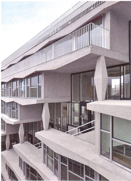
Ein Schräglift bricht sich durch die Fassade des Studierendenwohnheims von Eric Lapierre in Paris. → S. 56 Bild: Filip Dujardin
