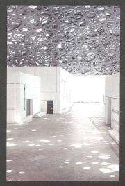
Eine Fläche von knapp 100 000 Quadratmetern umfasst der Museumsbau des Louvre in Abu Dhabi selbst. Seine Kuppel hat einen Durchmesser von 180 Metern, lagert nur an vier Stellen auf und besteht aus acht Schichten von Stahlornamenten, die ein sternförmiges Gitter bilden. Diese filtern das Licht wie ein Blätterwerk, lassen Helligkeit herein und schützen doch vor Hitze und Sonne.
