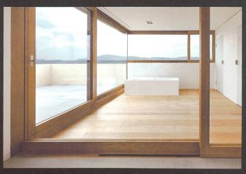
Aus der Mitte des Gebäudekörpers schiebt sich der vollverglaste Treppenhausturm des Einfamilienhauses durchgehend über alle drei Etagen prägnant heraus. FIN-Vista heisst das flexible und hochwertige Fensterwandsystem des Südtiroler Herstellers Finstral. Kern der tragenden Fensterwand ist eine Stahlkonstruktion, die mit Kunststoffprofilen ummantelt wird. Aussen und innen sind diese mit pulverbeschichteten Aluminiumprofilen verkleidet.
