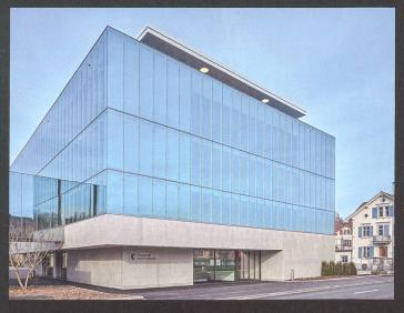
Spühler Partner Architekten aus Zürich haben für die Thurgauer Kantonalbank in Weinfelden einen eleganten fünfgeschossigen Glaskubus entworfen, der auf einem Betonsockel ruht und durch ein auskragendes Attikadach abgeschlossen wird. Der Erweiterungsbau der Bank bietet Platz für rund 100 Mitarbeitende.
