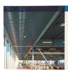
Extrem robust: Metalldecke mit Tiefzug-Lochung für eine Turnhalle
