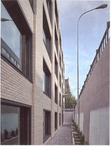
Das Bürogebäude ergänzt ein Blockrandfragment präzise, fügt sich mit seiner Backsteinverkleidung in die Nachbarschaft ein und fordert mit einer Brandwand zum Weiterbauen auf.
