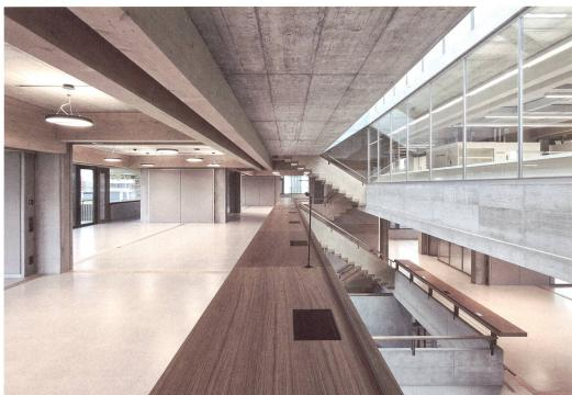
Die Tragstruktur aus Holz ist im ganzen Gebäude sichtbar und schafft direkte Bezüge nach aussen. Der Geländesprung wird im Innern des Gebäudes durch die vertikal versetzten Geschossflächen am zentralen Atrium abgebildet, das offene Layout wird so verdeutlicht.
