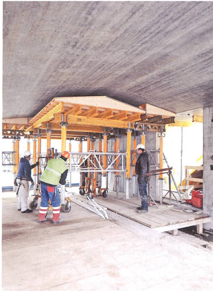
Die Schalung als Tempel: Abbau der Elemente, mittels derer die Beton-Faltdecken des St. Galler Bürogebäudes von Corinna Menn / Mark Ammann gegossen wurden. → S. 31 Bild: Menn/Ammann
