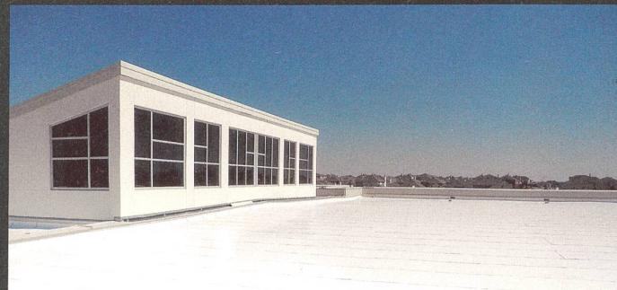
*Soprapstar* entspringt dem Know-how von Soprema, weltweit führend auf dem Gebiet der Abdichtung. Ihr grösster Trumf ist die Kühlhaltung von Bedachungen, die mithilfe eines hohen solaren Reflexionsvermögens von 0,78 und thermischen Emissionsgrads von 0,89 erreicht wird.
