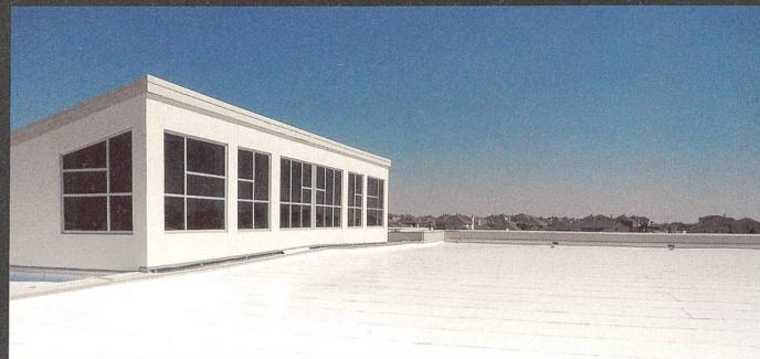
*Soprapstar* entspringt dem Know-how von Soprema, weltweit führend auf dem Gebiet der Abdichtung. Ihr grösster Trumpf ist die Kühlhaltung von Bedachungen, die mithilfe eines hohen solaren Reflexionsvermögens von 0,78 und thermischen Emissionsgrads von 0,89 erreicht wird.
