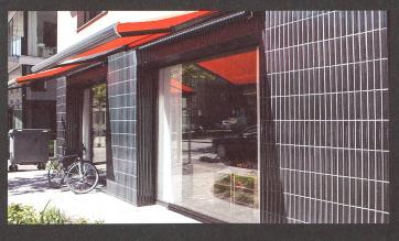
Energiesparend, schalldämmend, witterungsbeständig und dauerhaft schön: Keramische Wärmedämmverbundsysteme erfüllen alle Anforderungen an eine perfekte Gebäudehülle. Dabei erweist sich der keramische Belag nicht nur als langlebig und farbecht; die grosse Auswahl an Formaten, Oberflächen und Farben bietet zugleich enorme gestalterische Möglichkeiten. Sonderfertigungen eröffnen zusätzliche Freiheiten.
