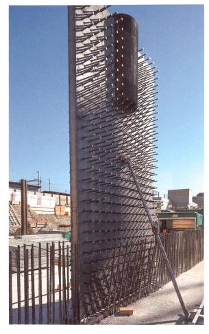
An den Vollstahlkern angeschweisst sind ein Stahlschwert und ein Bündel geneigter, hochduktiler Schraubarmierungseisen mit Kopfbolzendübeln, welche die ungeheuren Kräfte des hier lastenden Mitteltrakts in die Vertikale zwingen.
