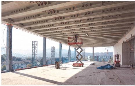
In der regelmässigen und feinen Struktur verbirgt sich ein eigentlicher Stahlbau. Im Bild Lehrgerüst und Krafteinleitung des Mitteltraktes in
