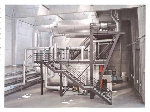
fachungen aus Ortbeton ein Raumgefühl von atmosphärischer Dichte: den Eindruck einer Kathedrale der Energieumwandlung mit zwei Grossbrennkesseln, Kamin-Schalldämpfern und einem gigantischen Wärmespeicher, der vom Untergeschoss bis unters Dach reicht. Zwei Farben dominieren: Silbernes Blech ummantelt sämtliche Anlagen, und dunkelbraune Stahlpodeste für den Unterhalt bilden das Bindeglied zwischen Haus und Maschine.
