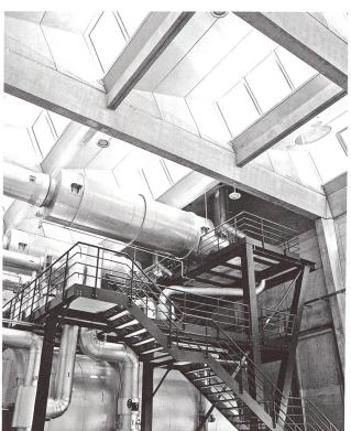
Der vorgespannte Betonbau ist modular aufgebaut und wird schliesslich an drei Standorten in St. Gallen realisiert. Durch sein Sheddach mit quadratischen Feldern dringt Nordlicht. Die Schrägen dienen Solarpanels.Bilder: Katalin Deér
