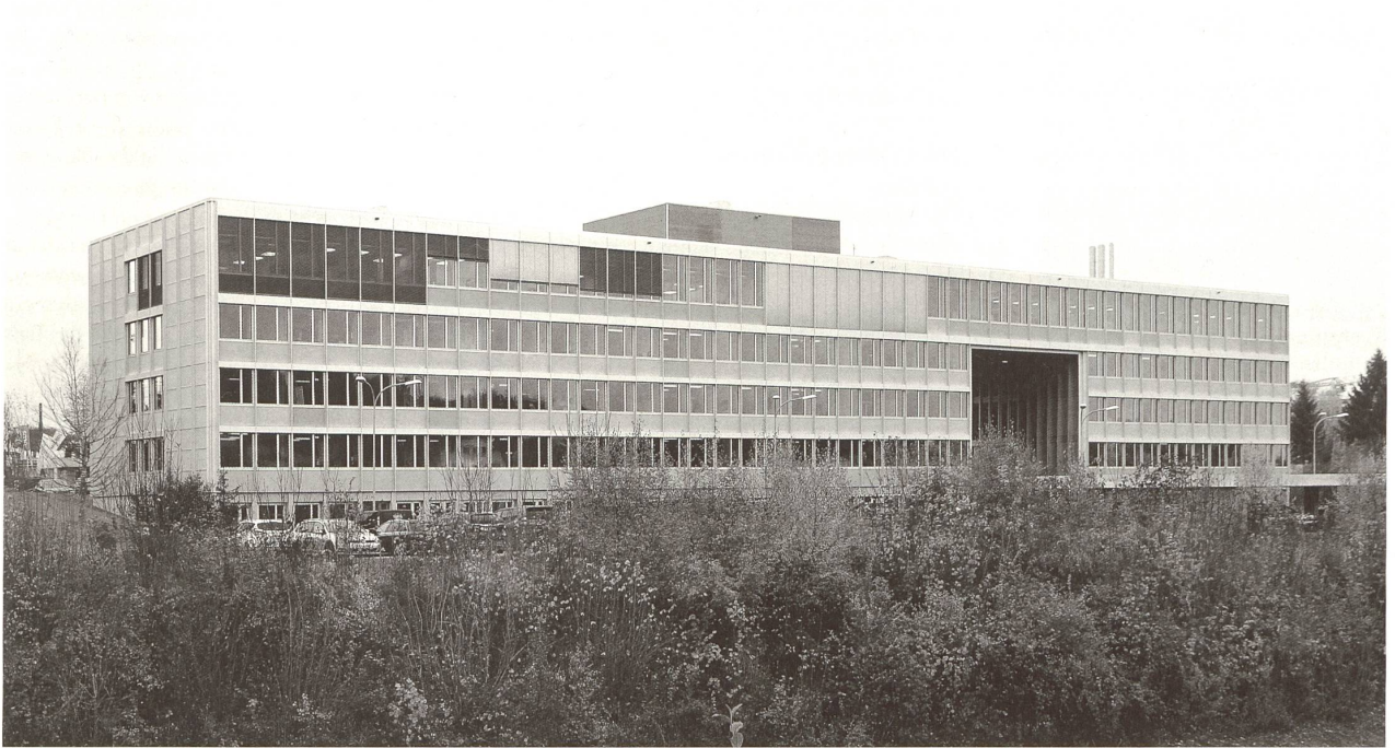
Umgang mit dem Baudenkmal in Givisiez: Aus dem Baudenkmal des ehemaligen Autobahnamts wurde mit neuer Fassade und dem An- und Aufbau ein Neubau – im besonderen Fall hier durchaus zu Recht. Bild: Bernhard Furrer,
