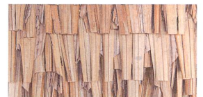
Palmenblätter: Das Material eignet sich durch seine hohe Wärmeisolation und Wasserdichtigkeit gut zur Dacheindeckung.
