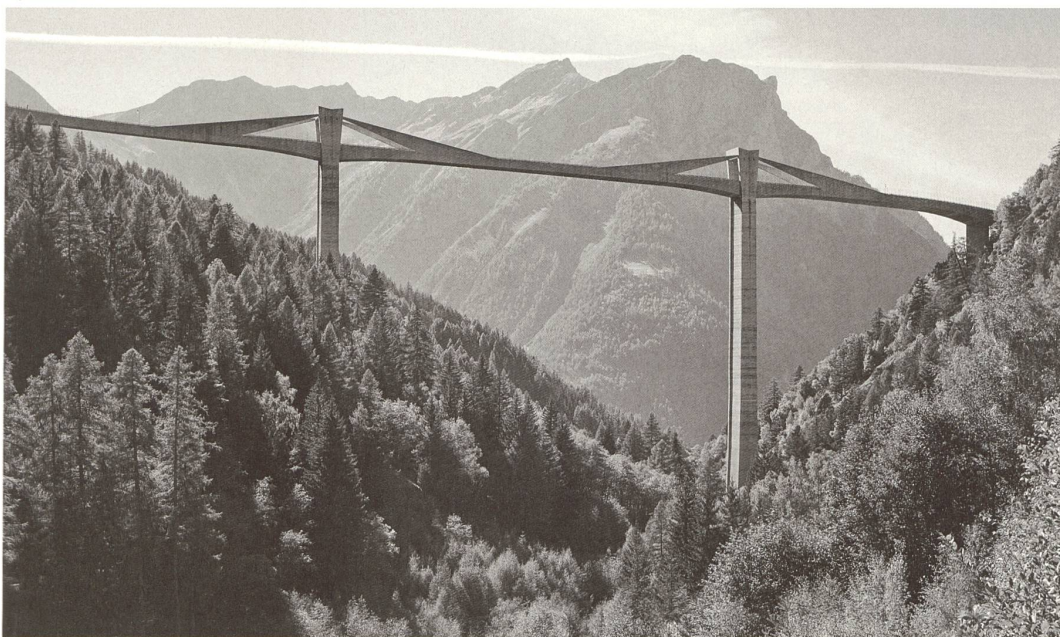
Neue Ganterbrücke an der Simplon-Passstrasse von Christian Menn, 1980. Bild: Ralph Feiner
