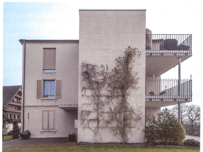
Die Aufstockung eines spätklassizistischen Wohnhauses übernimmt die Fensterachsen des Bestandes (Gerold Kunz 2017).
