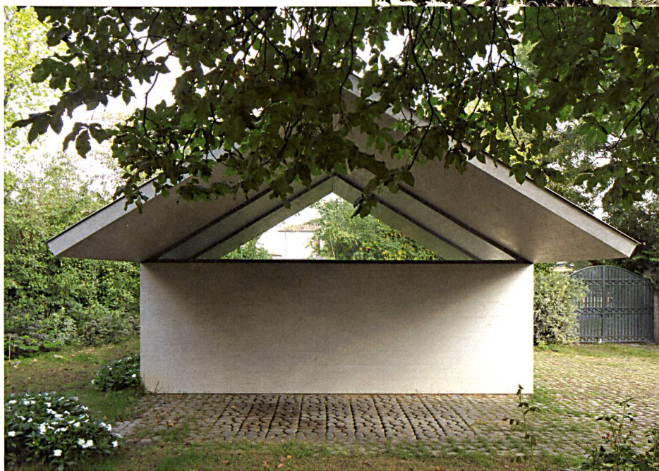
Ein Gartenhaus im Garten, im Niemandsland. Die prekären Auflager der auskragenden Dach-Scheiben sind in der abstrakten Kom- position verborgen.
