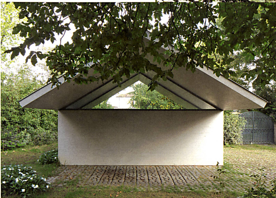
Ein Gartenhaus im Garten, im Niemandsland. Die prekären Auflager der auskragenden Dach-Scheiben sind in der abstrakten Kom- position verborgen.
