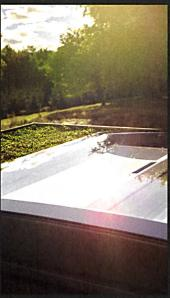
Die gleichmässige Biegung des Bogenglases maximiert den natürlichen Lichteinfall, zudem lässt die Formgebung Regenwasser problemlos ablaufen und verhindert Ablagerungen von Schmutz und Blättern, was den Wartungsaufwand erheblich verringert. Das Bogenglas kann als unauffällig integriertes Dachelement oder aber bewusst als gestalterisches Element eingesetzt werden.
