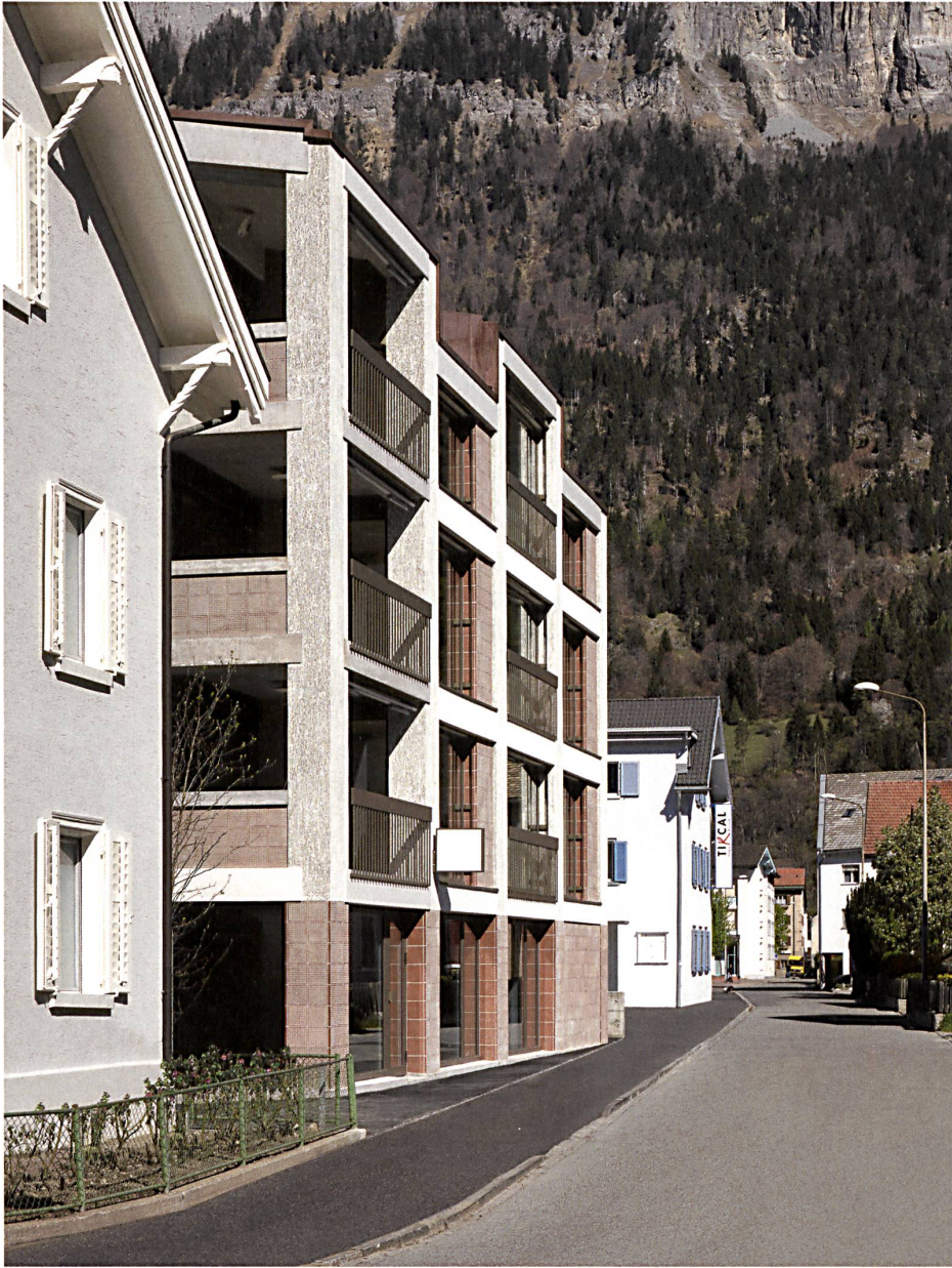
Ein Einzelbau zwischen Einzelbauten – etwas grösser zwar ist das Haus von Aita Flury, aber doch von seinesgleichen. Palladianische Ordnung schafft Identität in Domat-Ems; im Erdgeschoss ein Ladenlokal. Bild: Ralph Feiner
