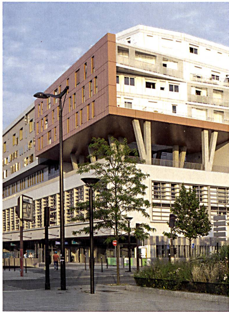
Über dem Lagerhaus Entrepôt Macdonald in Paris erhebt sich als Aufstockung ein ganzes Stadtquartier. Im Bild: Bauteil von Christian de Portzamparc. → S. 14 Bild: Thomas Mayer
