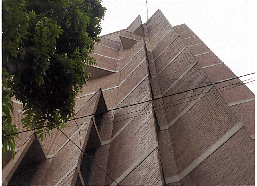
Eine kiemenartige Backsteinkruste schützt die Innenräume vor direktem, gleissendem Sonnenlicht und vor dem Lärm der im Verkehrschaos ertrinkenden städtischen Hauptschlagader der Mirpur Road.
