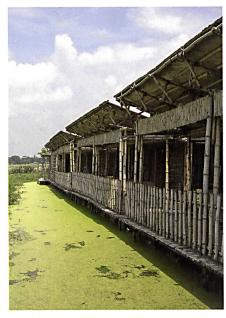
Eine amphibische Architektur hebt den Gegensatz zwischen Land und Wasser auf. Gelagert auf rezyklierten Ölfässern funktionieren die Schulpavillons gleichermassen während der Flut- wie auch der Trockensaison.
