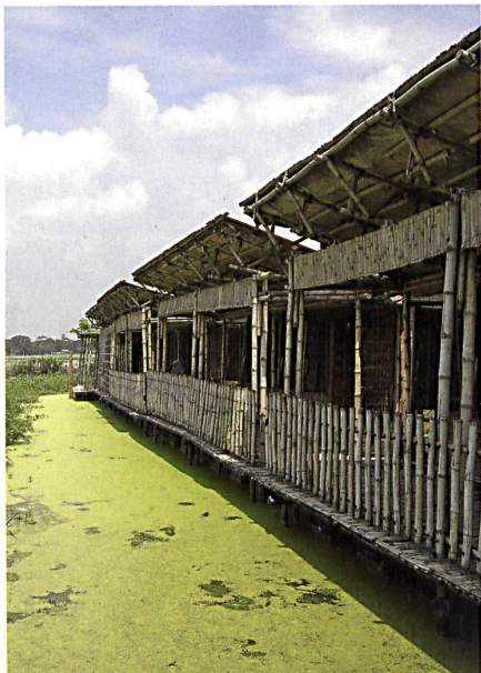
Eine amphibische Architektur hebt den Gegensatz zwischen Land und Wasser auf. Gelagert auf rezyklierten Ölfässern funktionieren die Schulpavillons gleichermaßen während der Flut- wie auch der Trockensaison.
