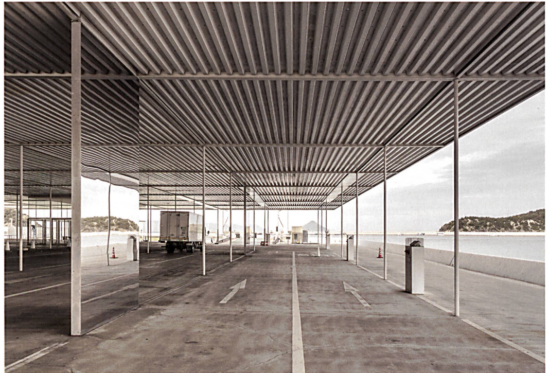
Ein grosses Dach überdeckt am Fährhafen in Naoshima den von Fussgängern und Fahrzeugen geteilten Raum, ohne Hierarchie. Bilder: Rasmus Hjørtshøj – COAST
