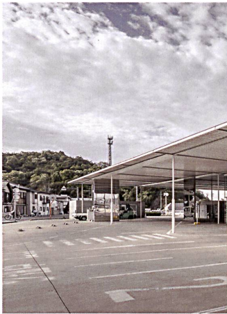
Fährterminal Naoshima Miyaura Port, Kagawa, Japan Bauherrschaft Naoshima Town Architektur Kazuyo Sejima, Ryue Nishizawa, Rikiya Yamamoto, Erika Hidaka Fachplaner Tragwerk: Sasaki Structural Consultants HLKS: Kankyo Engineering Geschossfläche 1915 m 2 Chronologie Entwurf Oktober 2003 – Juli 2005 Bau Oktober 2005 – September 2006
