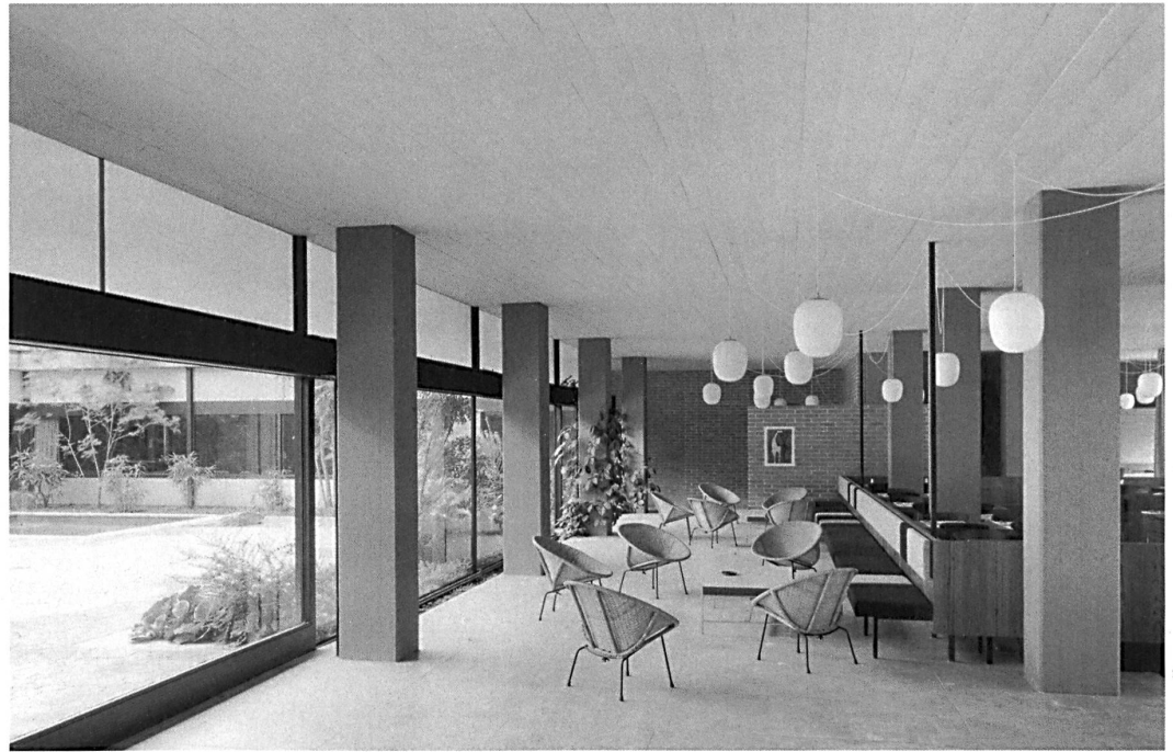
Frei stehende Stützen strukturieren den fließenden Raum: Bistro im Farelhaus Biel unmittelbar nach Fertigstellung um 1959. Bild: Archiv Farelhaus AG
