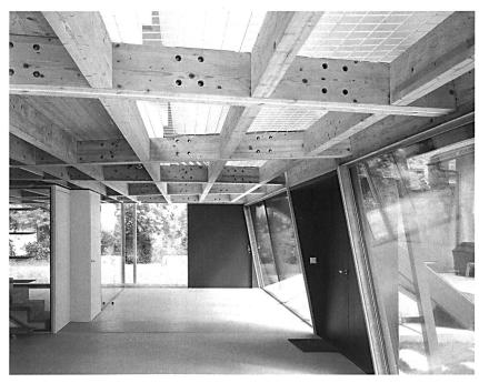
Eine hybride Konstruktion aus Stahlrahmen und Holzdecken definiert den Neubau. Das alte Presshaus wurde als gleichwertiger Projektteil grundlegend renoviert und umgebaut. Bilder: Joël Tettamanti
