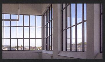
Wärmegedämmte Festverglasungen und Fenster mit einer bisher unerreicht schlanken Ansichtsbreite von 23 mm für Verglasungen und 55 mm (Fenster-/Stulpflügel) ermöglicht das Profilsystem förster unico XS.
