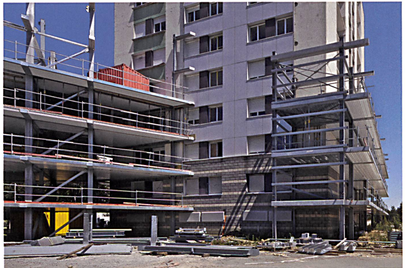
Renovation und Erweiterung statt Abbruch, Ergänzungen aus Stahl: neue Wohnflügel (links) sowie Wintergartenzonen und Balkone für den Bestand (rechts).
