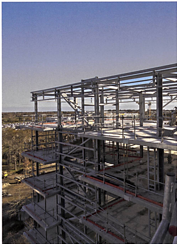
Erprobtes Grundprinzip: Einfachste Stahlstruktur als Industrieprodukt, Addition eines Wintergartens als Pufferzone, umlaufende Balkonschicht.
