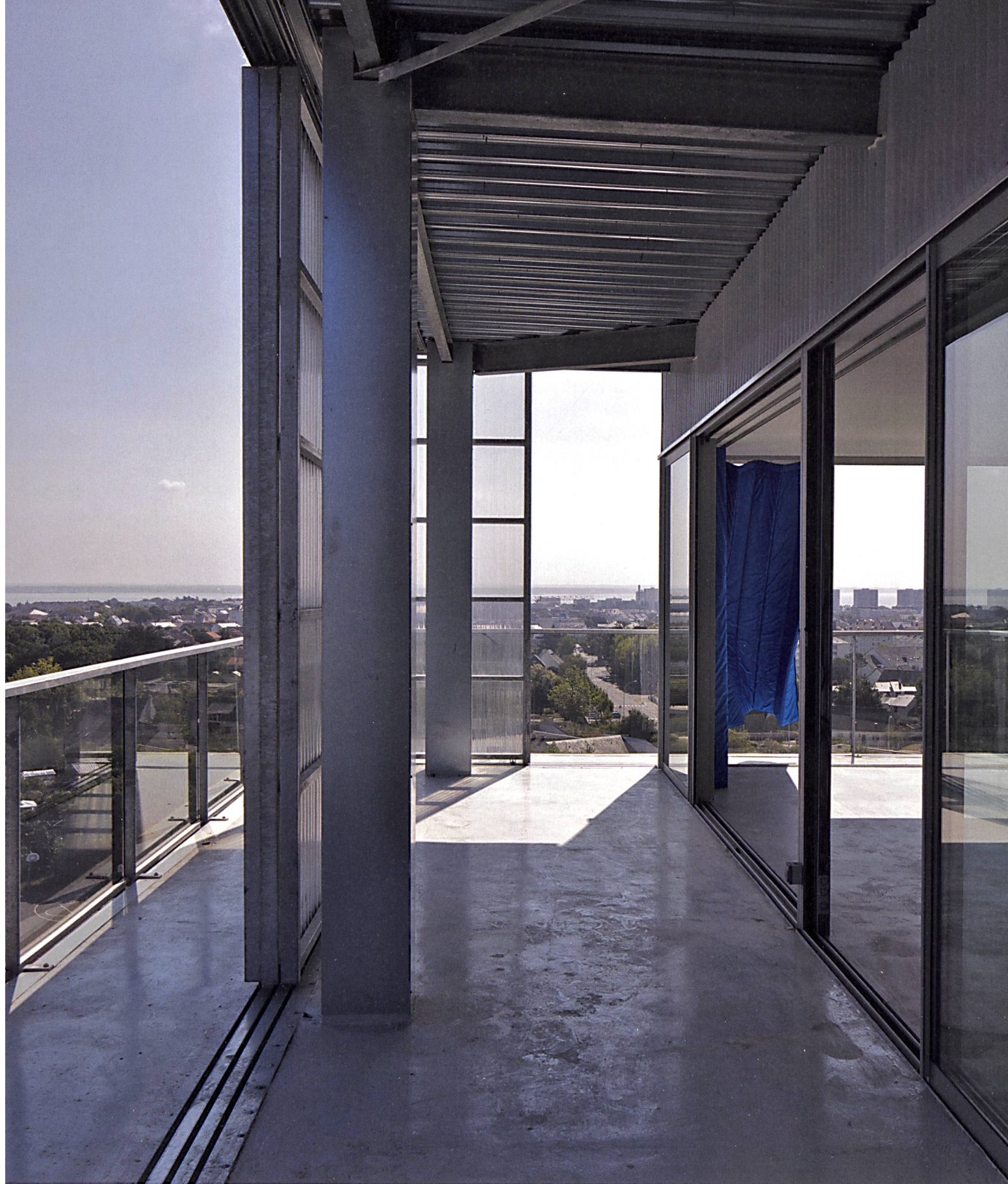
Der freie Blick bis zum Atlantik soll nicht getrübt werden: Stahlbleche verkleiden die unansehnliche Brandschutzschicht der Stützen.
