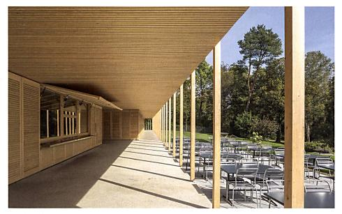
Wie erwartet hat die Witterung die Stützenreihen aus unbehandelter Weisstanne gut vergrauen lassen. In mal engen, mal weiteren Abständen tragen sie umlaufend den dünnen Rand des Flachdachs. Hinter den spinnenbeinigen Stützen der schlanken Leimholzkonstruktion führen hölzerne Lamellenelemente das Bild der leichten Sommernutzung weiter. Im Schatten unter dem ausgreifenden Dach schätzt der Sommergast die angenehme Kühle, die von der geschliffenen Betonplatte ausgeht, auf der der Holzbau steht.
