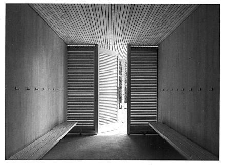
Unter dem ausladenden Vordach sind die beiden Baukörper in eine Schicht aus hölzernen Lamellenelementen gehüllt. Bereichsweise sind sie aufklappbar und öffnen den Zugang zu Kiosk oder Funktionsbereichen wie den Garderoben (unten). Bilder: Hanspeter Schiess / Cukrowicz Nachbaur
