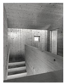
Der Strickbau und das Natursteindach nehmen lokale Bautraditionen wieder auf. Das Haus ist jedoch gedämmt und das Holz auf der CNC-Maschine abgebunden. In Schlosserdetails wie Griffen, Haken bis hin zu Lampenfassungen tritt die handwerkliche Finesse hervor. Bilder: Lucia Degonda
