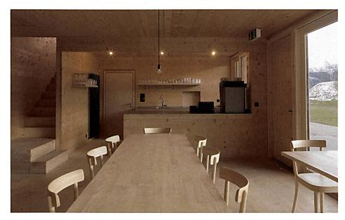
Blumenthal auch für den länglichen Neubau am besten geeignet. Mit einem massiven Holzbau aus unbehandelter Rottanne entwarfen sie zum eingeladenen Wettbewerb von 2012 ein Haus, das ins Tal passt und gewannen. Als zeitgemässer Strickbau mit plastischen Qualitäten knüpft er direkt an eine jüngere Bautradition in der Gegend an. In seiner Bautypologie mit unterschiedlichen, teils saisonalen Nutzungen unter einem Dach klingt ein wichtiger Bestandteil der hiesigen Baukultur von früher an.
