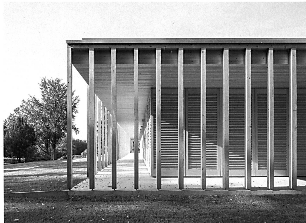
Je nach Achsbreite der umlaufenden Holzstützen werden Wege durch den Pavillon oder Ausblicke in die Parklandschaft des Bads freigespielt. Bild: Hanspeter Schiess / Cukrowicz Nachbaur.
