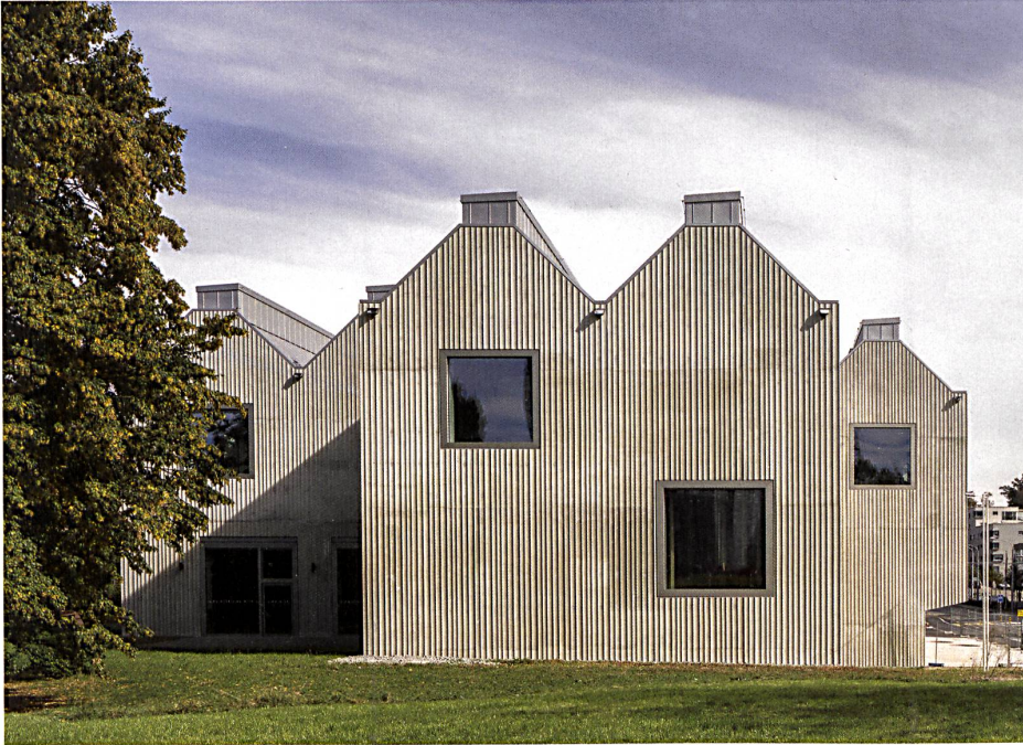
Ambiguität macht den Reiz: Gewächshaus-Dächer und kannelierte Fassaden verorten den Bau zwischen Agro-Industrie und Kunstmuseum um 1900. Der Eingang ist auch eine Bushaltestelle.
