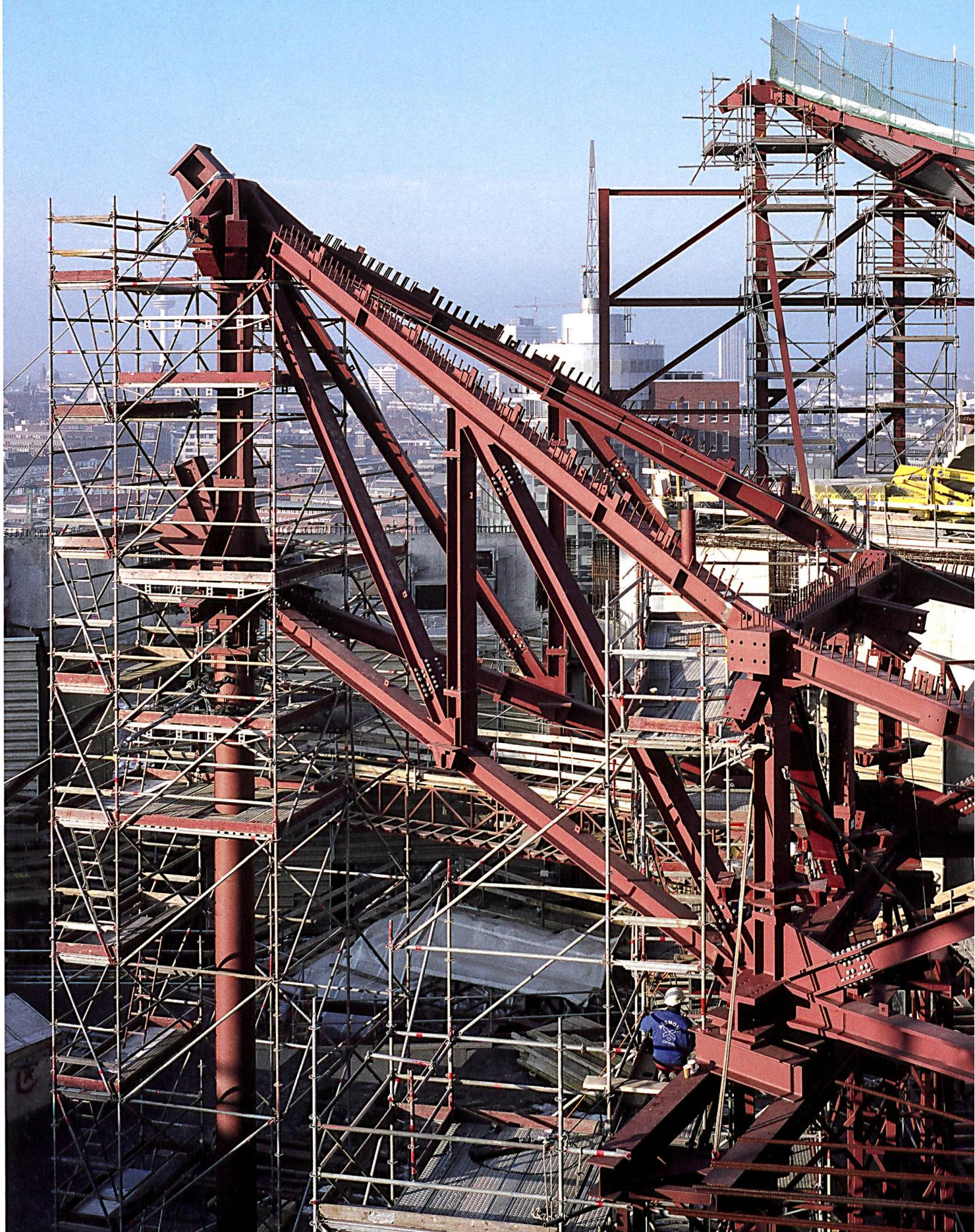
Wie ein Strohhut mit breiter Krempe: Der Ring des stehenden Fachwerks erhebt sich über der äusseren Schale des grossen Saals. Die konzentrischen Fachwerkträger kragen weit über diesen aus und tragen den flachen Kegelstumpf, der als Zugring wirkt. Nur durch die Auflösung der unregelmässigen Geometrie in finite Einzelelemente liessen sich die Kräfte im Dach berechnen.
