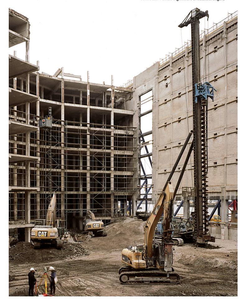
Über der bestehenden Pfahlfundierung und dem neuen Tragwerk des Speichers ist der grosse Saal an wenigen schrägen Stützen aufgehängt. Die Rippen seiner äusseren Schale erinnern an Kiel und Spanten eines Bootes.
