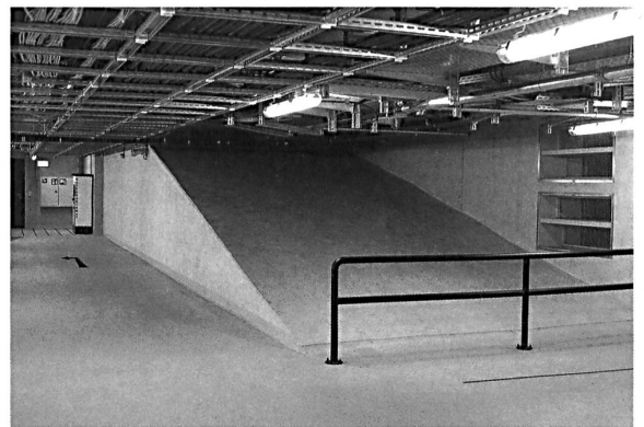
Parkgeschoss mit Abbild der Rolltreppen-Röhre
