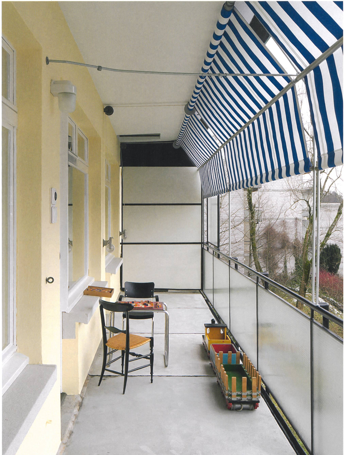
Die Terrassen vor dem Obergeschoss – 1931 (rechts) und 2015. Alle konstruktiven Elemente sind original erhalten, nur der Betonüberzug des Bodens ist neu. Bild rechts: gta Archiv, ETH Zürich, Nachlass Werner M. Moser.
