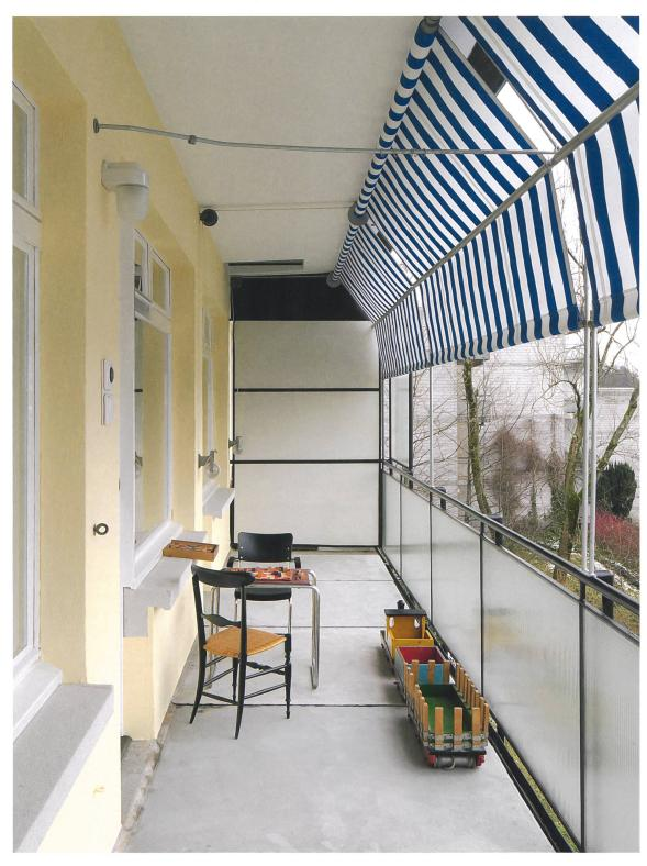
Die Terrassen vor dem Obergeschoss – 1931 (rechts) und 2015. Alle konstruktiven Elemente sind original erhalten, nur der Betonüberzug des Bodens ist neu. Bild rechts: gta Archiv, ETH Zürich, Nachlass Werner M. Moser.
