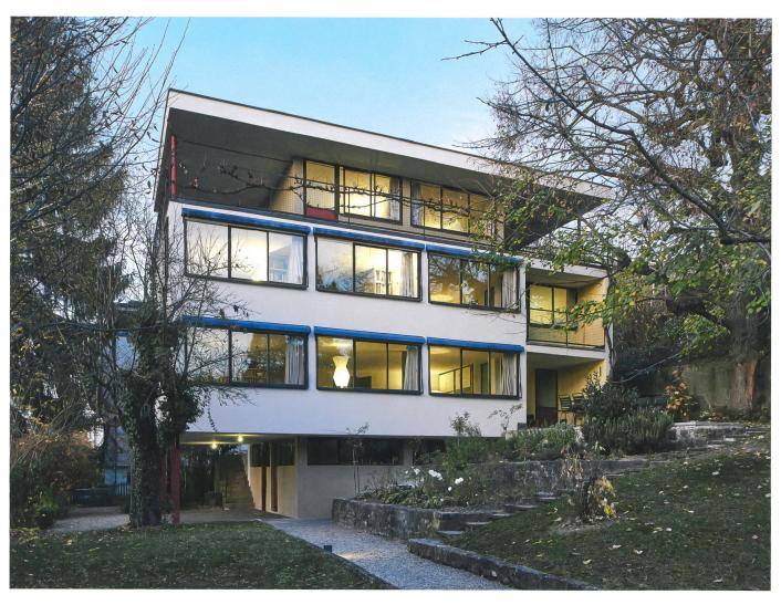
Fünf Punkte für Riehen: Pilotis, Dachterrasse, Bandfenster, freie Fassade und freier Grundriss machten den Stahlbau zum Zeugen einer sachlichen Moderne.
