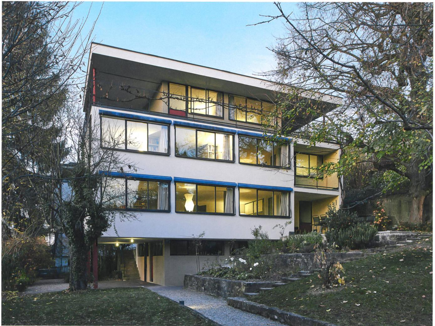
Fünf Punkte für Riehen: Pilotis, Dachterrasse, Bandfenster, freie Fassade und freier Grundriss machten den Stahlbau zum Zeugen einer sachlichen Moderne.
