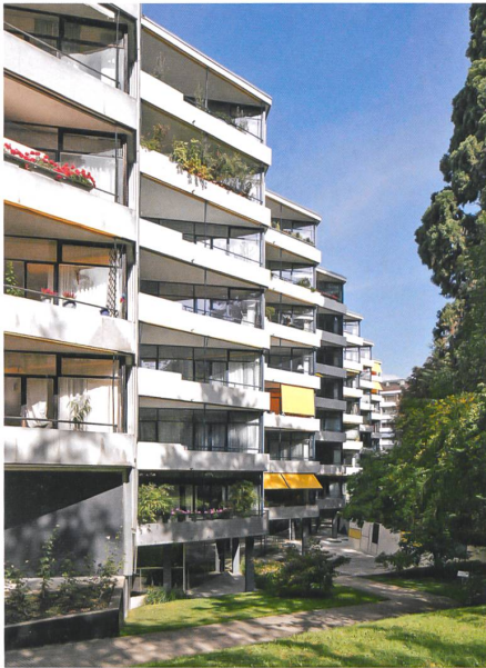
Leicht, transparent und innovativ: Die Genfer Wohnhäuser Miremont-le-Crêt von Marc-Joseph Sauguey wurden behutsam erneuert. → S. 36 Bild: Yves André
