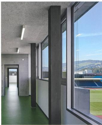
Schwarze Stützen im Innern ermöglichen lange Fensterbänder, durch die der Kasernenturm von Armin Meili in der Ferne in den Blick fällt (Bild rechts).
