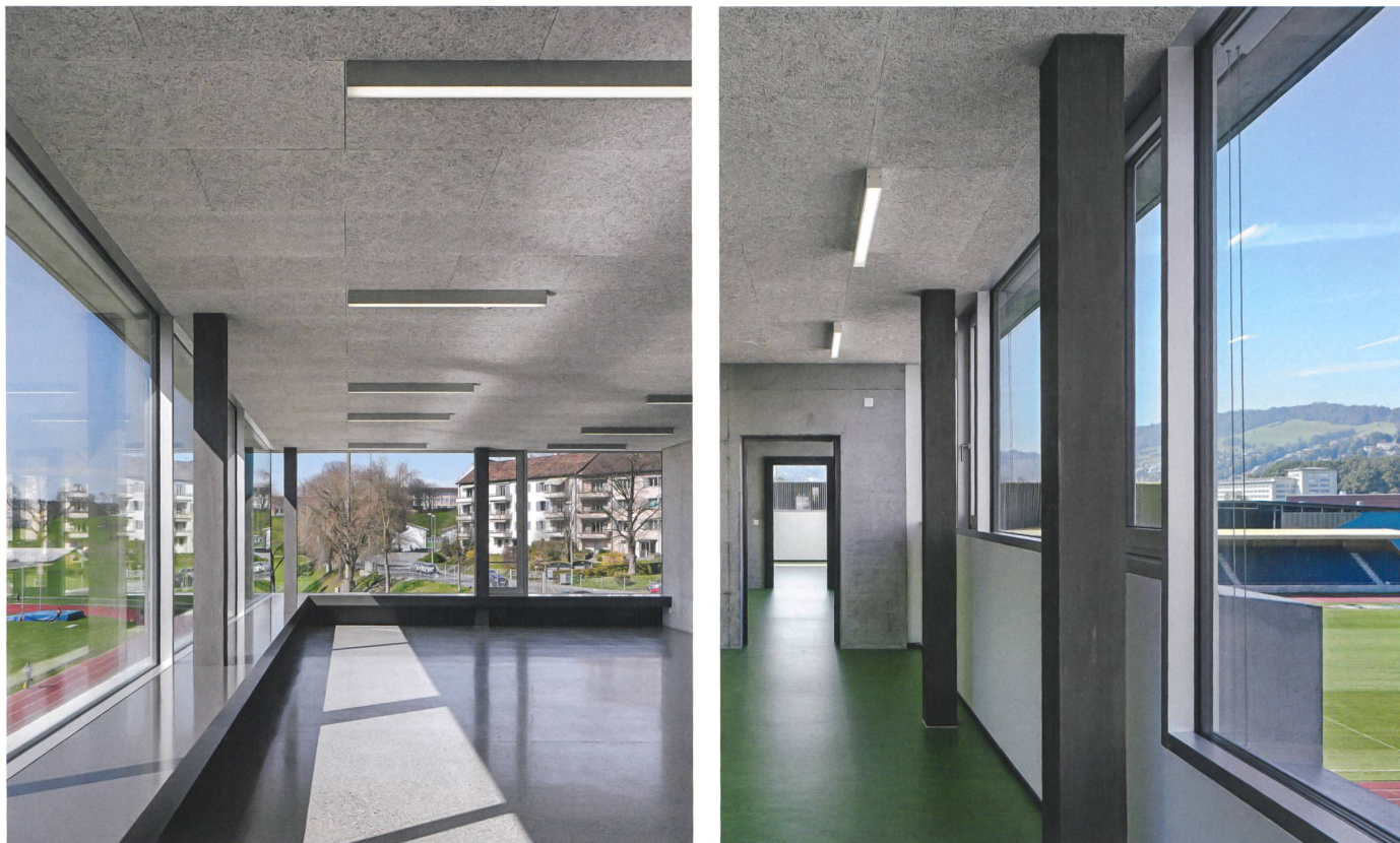
Schwarze Stützen im Innern ermöglichen lange Fensterbänder, durch die der Kasernenturm von Armin Meili in der Ferne in den Blick fällt (Bild rechts).
