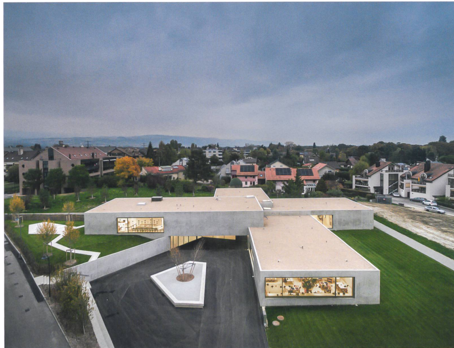
Vier einzelne Gebäudeflügel, in der Höhe um je ein Drittelgeschoss versetzt, verzahnen sich zu einer kreuzförmigen Anlage. Mensa und Hort bilden den obersten Flügel, der die Eingangshalle überspannt.
