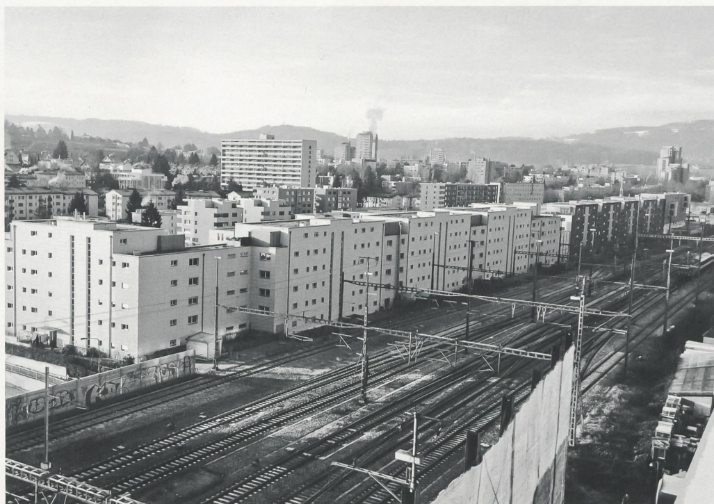
Wenn keine Lüftungsfenster mehr möglich sind, sehen Strassenfassaden bald aus wie an der Bahnlinie in Schlieren. Bild: Caspar Schärer
