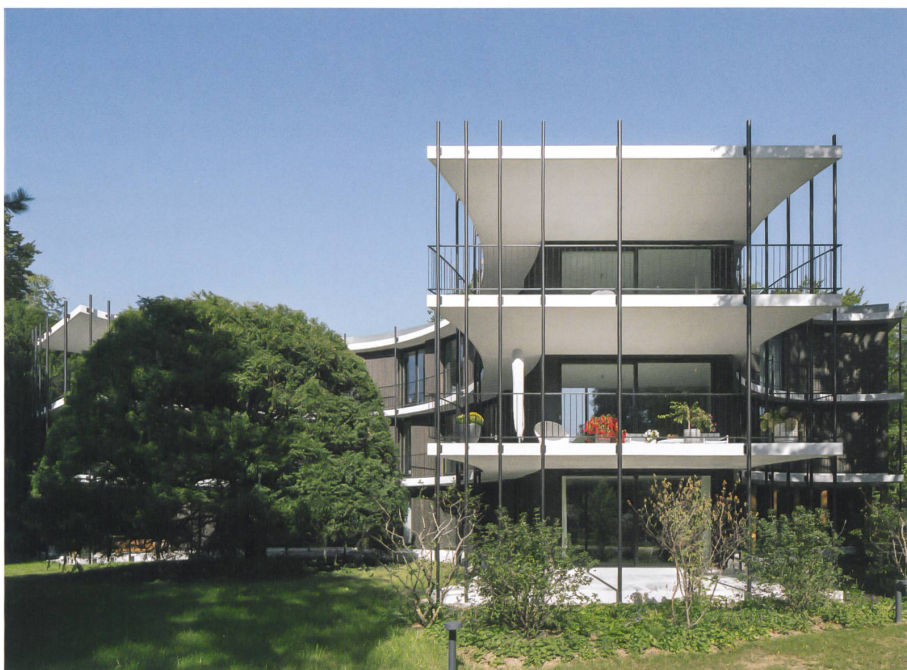
Ausschwingende, weisse Balkonplatten lassen Raum für die geschützte, buschige Eibe. Sie kontrastieren mit den schlanken Stützen und der dunkel gebeizten Holzfassade.
