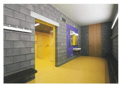
wissen Ausdruck der ungekünstelten Schlichtheit bewirken. Während die horizontalen Fugen des Mauerwerks zurückversetzt abgezogen sind, wurden die vertikalen Fugen unsichtbar in der Mauertiefe vermörtelt. Dies betont eine horizontale Schichtung, zugleich wirkt sich die Porosität des Mauerwerks aber auch vorteilhaft auf die Raumakustik aus.
