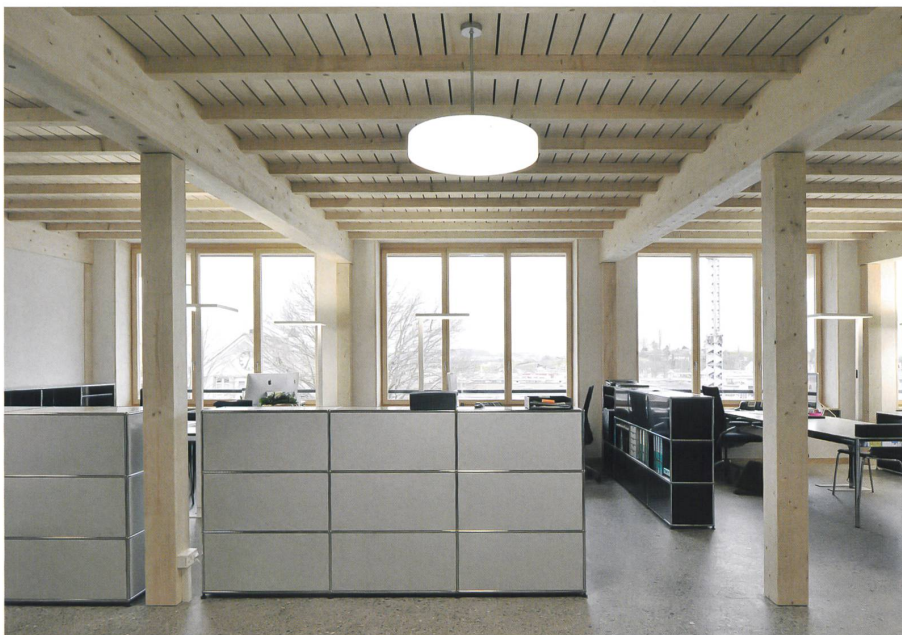
Sichtbare Holzkonstruktion und geschliffener Betonboden im zweiten Obergeschoss des Gartenbauwerkhofs in Winterthur-Hegiberg.
