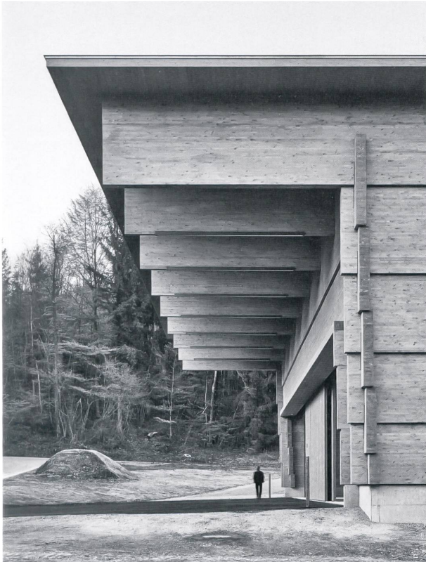
Die obersten Wandelemente kragen über dem östlichen Vorplatz aus. Bild: Jürg Zimmermann
