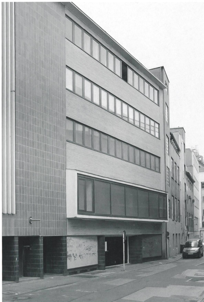
Rückfassade in Essen. Bild: Benedikt Redmann
