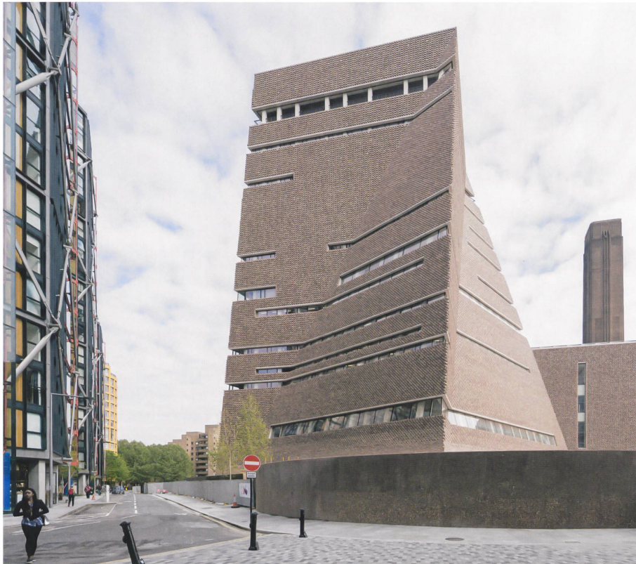
Die verdrehte und geknickte Klinkerhaut auf dem Stahlbetonskelett überzeugt in seiner Rustizität und Plastizität und lässt keinen verlässlichen Eindruck des Massstabs zu.
