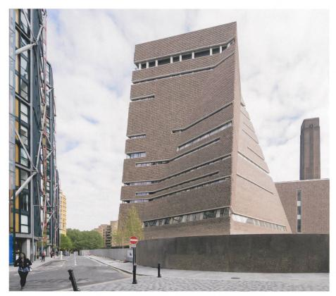
Die verdrehte und geknickte Klinkerhaut auf dem Stahlbetonskelett überzeugt in seiner Rustizität und Plastizität und lässt keinen verlässlichen Eindruck des Massstabs zu.
