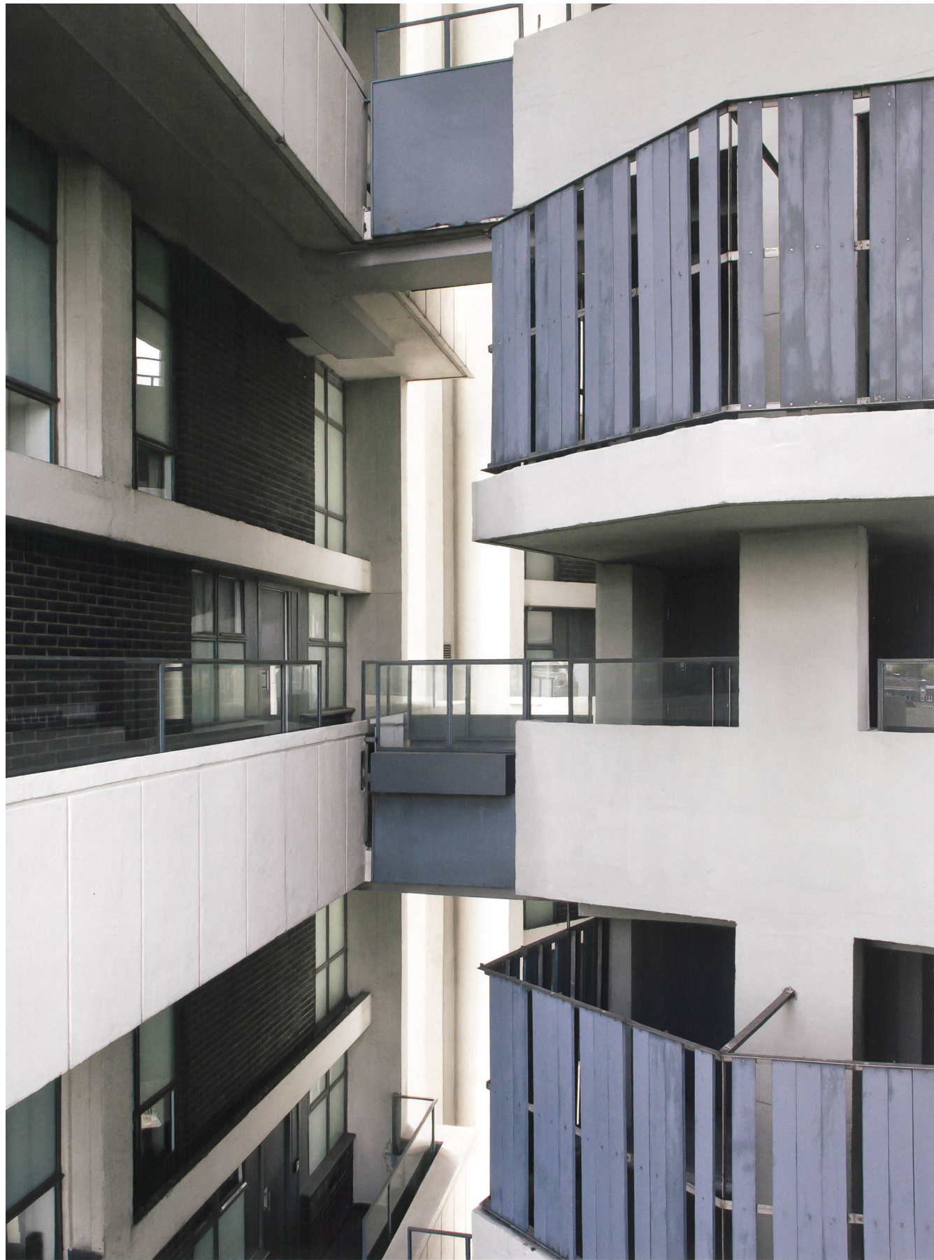
Die Maisonettewohnungen sind über Laubengänge an der frischen Luft erschlossen: Das Dazwischen als Kontakt- und Konfliktzone.
